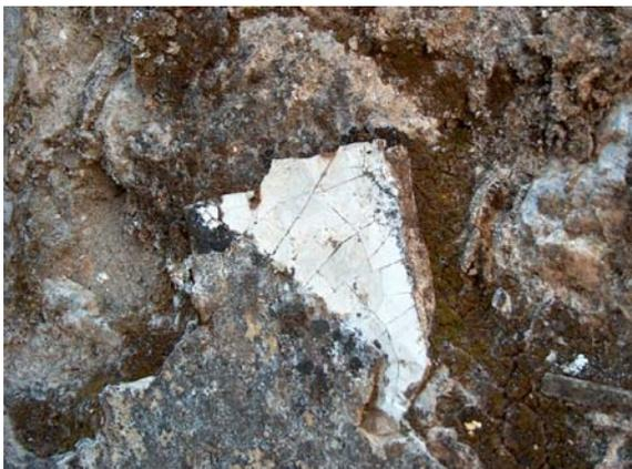
Detalle de las tortas de enlucido de cemento "moderno" en masa destinadas a eliminar las filtraciones.
