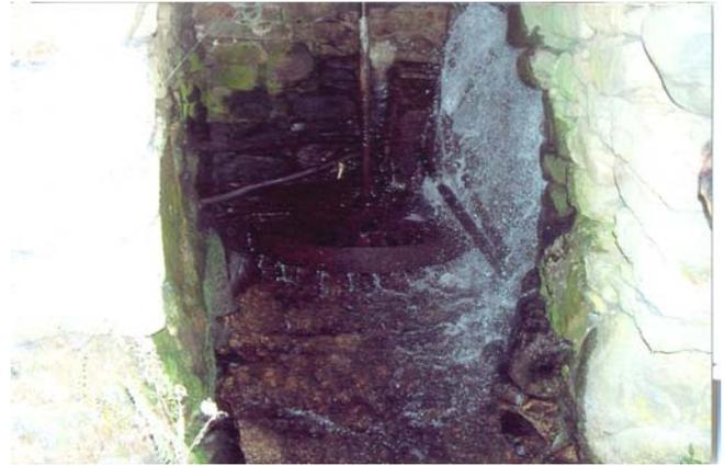
Detalle de un rodezno de un molino todavía en funcionamiento en Zorita de los Molinos (Ávila)
